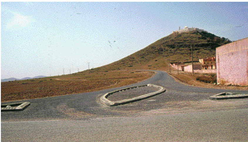
Route rurale reliant les communes de Aït Milk à Belfâa
