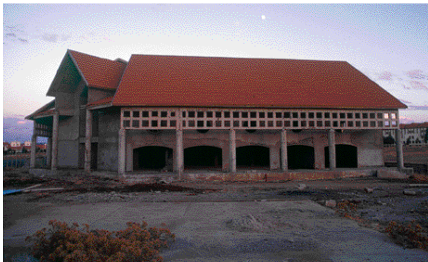
Construction du centre d'accueil de Michlifen par le Conseil Provincial d'Ifrane financée par le FEC en 1999
